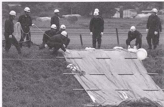
▲飯樋川堤防での水防訓練（シート張り工法）
