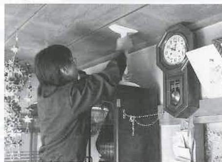
▲天井と家具の間に支えボールを取り付ける協力員
