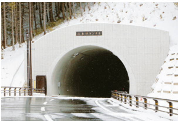
石ポロ坂トンネルを原町方面に抜けると間もなく入り口が見えてきます。道路舗装も真新しく
