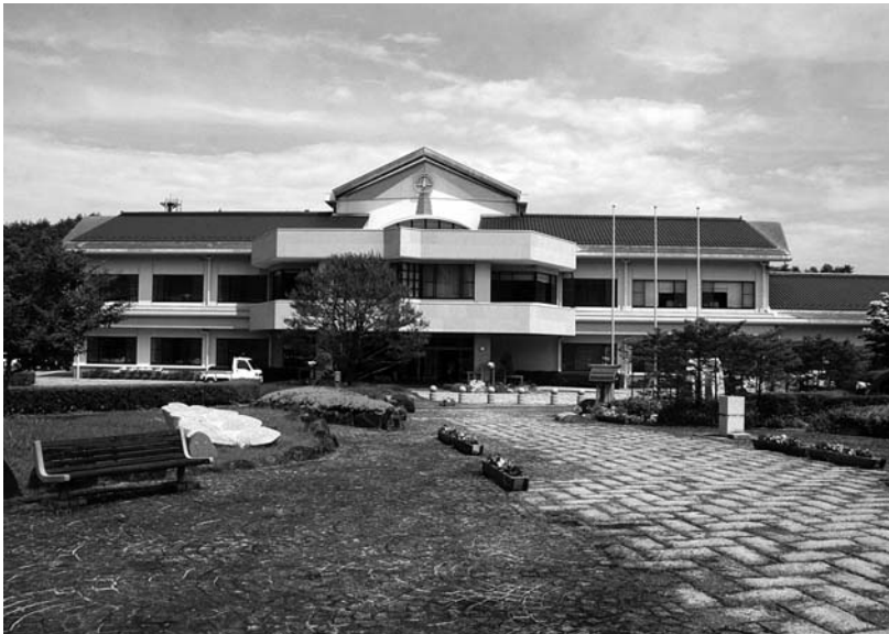
▲庁舎内エアコン導入
