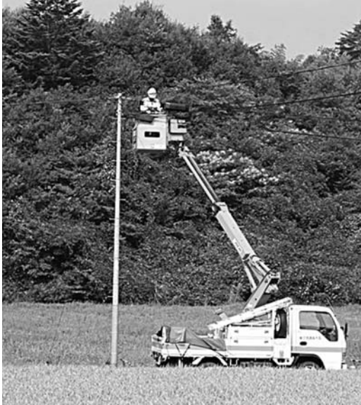
▲工事が進む光ファイバ
