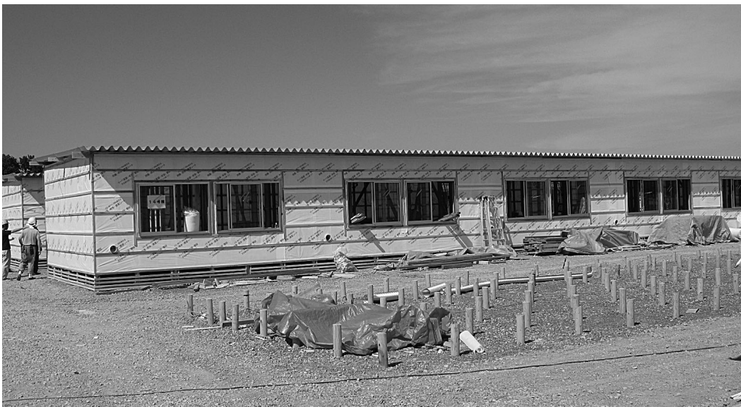
▲建設中の仮設住宅
