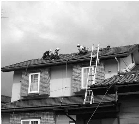
除染作業(住宅)の様子
