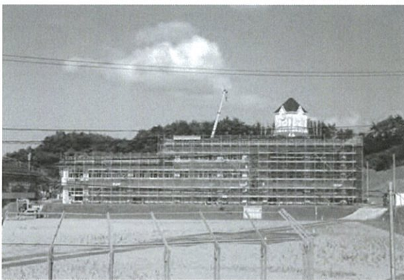
▲改修工事が始まった飯館中学校
