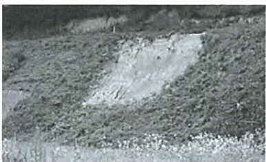
▲野手神の被害状況
