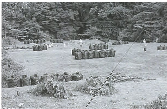
▲仮々置き場に運び出すフレコンバック
