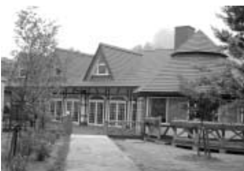
▲新たに建設された「きこり別館」
