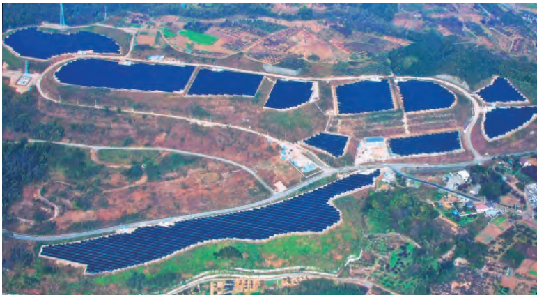
▲メガソーラー施設の全景(航空写真)
