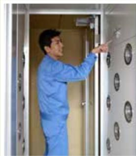
各工場の入口には、ほこりを落とすためのエアシャワーが設置されています。放射性物質を工場内に持ち込まないための装置です。
