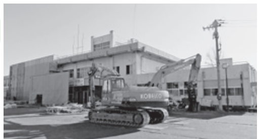
▲解体工事が始まった村公民館
