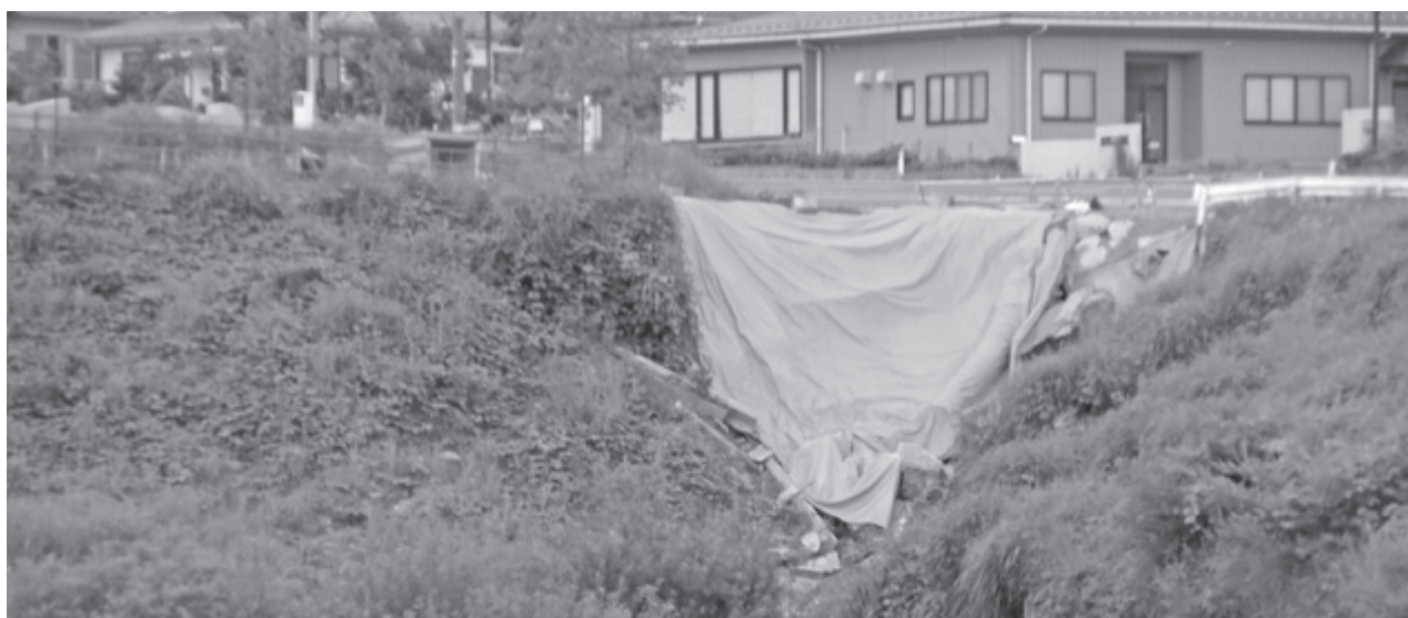
▲予算化されたセンター地区調整池の工事予定場所
