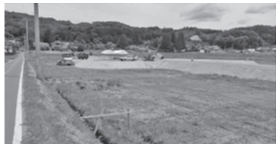
▲盛り土が始まった深谷拠点整備地区
