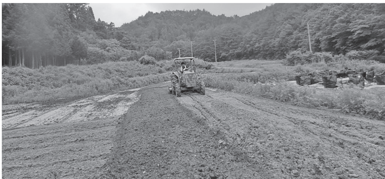
▲営農再開に向けての作業
