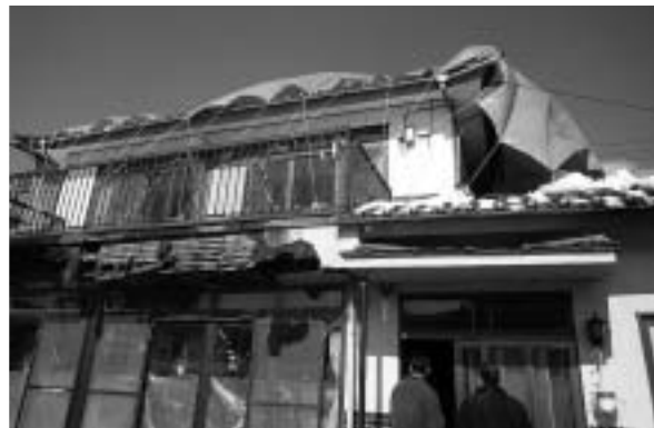
▲地震によって被害を受けた家屋
