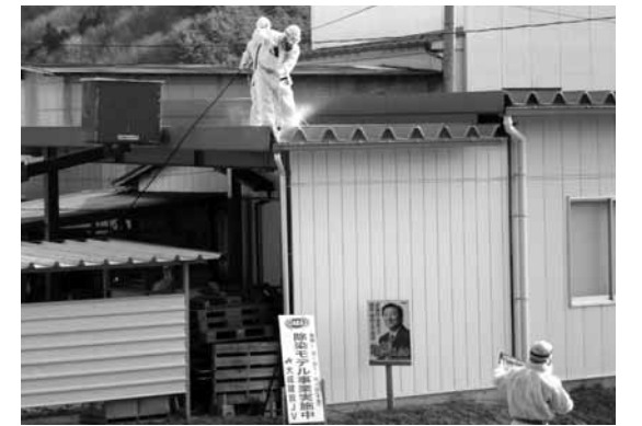
▲工場施設の除染の様子
