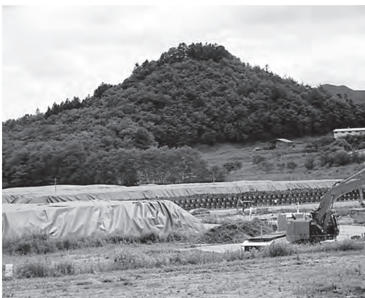
▲山積みになっているフレコンバッグ
