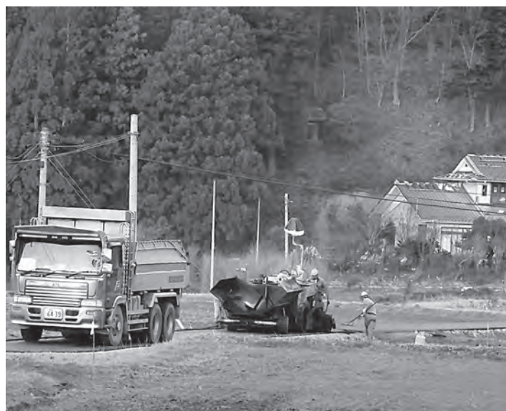
昇口舗装の様子
