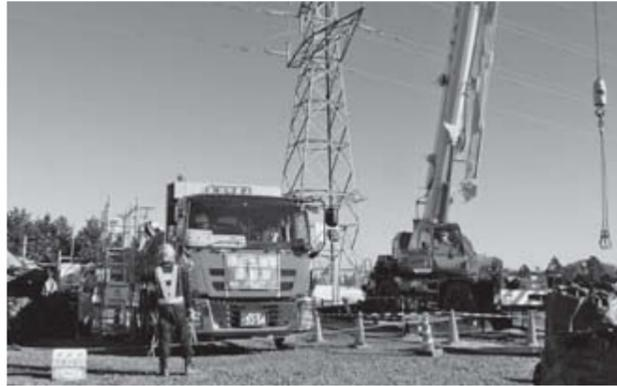
▲大型土のう袋をクレーンで積載しシートで覆います
