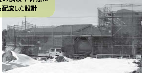
消防分署の建て替え工事
