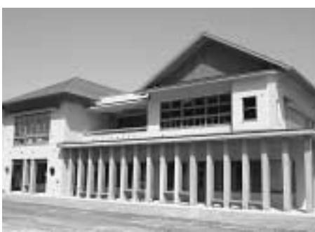
▲3月に完成した飯樋小学校南校舎
