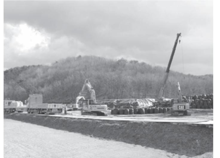
除去物を詰めたフレコンバッグは仮置き場で一時管理します
