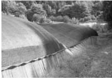
▲強風で折れ曲がったパイプハウス
