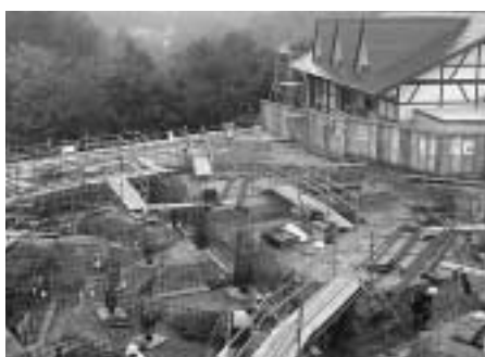
▲建設工事が進むきこりの新しい入浴施設
