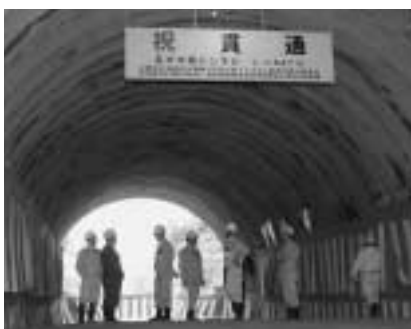
▲貫通した石ボロ坂トンネルの全長は647m
