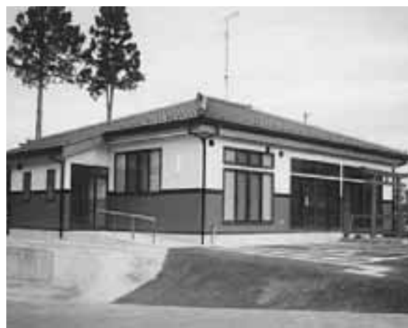
▲完成した11区八和木集会所
