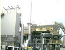
排ガス処理装置などによる放射性物質対策
