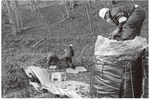
▲須萱地区での除染工事の様子
