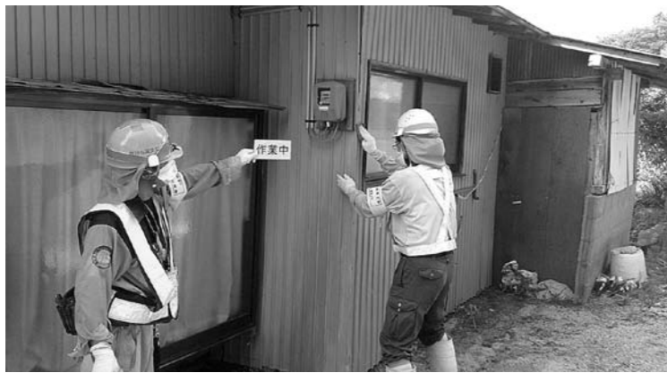
▲壁面の除染は表面を拭き取ります (大久保・外内)
