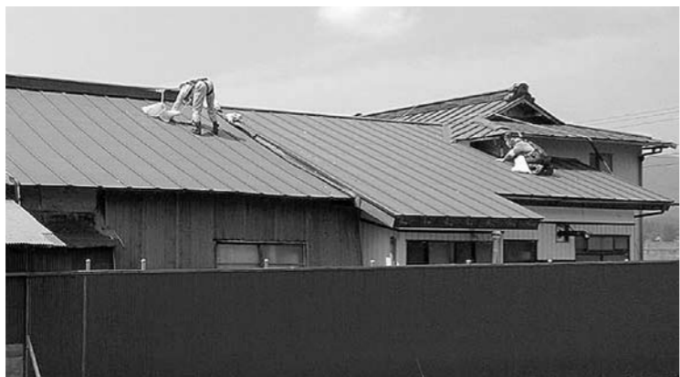
▲屋根の除染作業のようす (大久保・外内)
