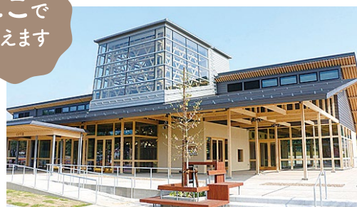
いいたて村の道の駅までい館
