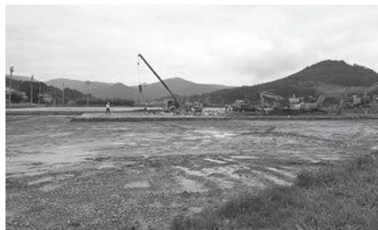
▲施設工事の様子
