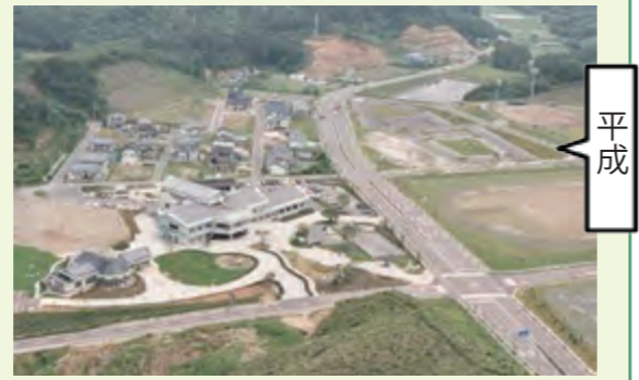
平成 新庁舎の完成は平成5年。庁舎左手に、同7年開店の「ほんの森いいたて」も写る航空写真。
