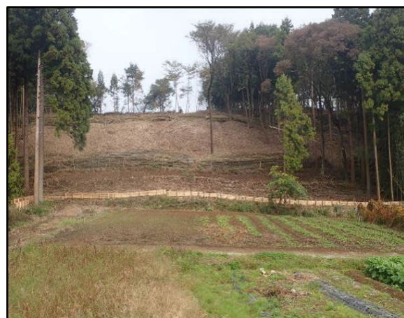
丸太柵工による放射性物質対策のイメージ
