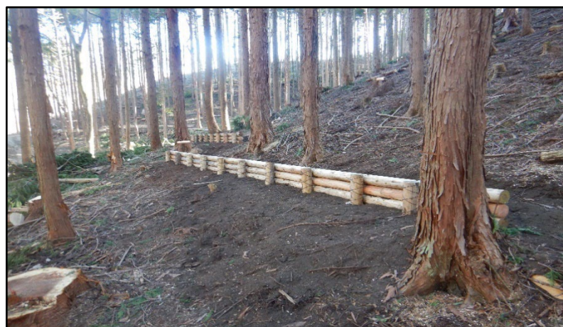
丸太筋工による放射性物質対策のイメージ
