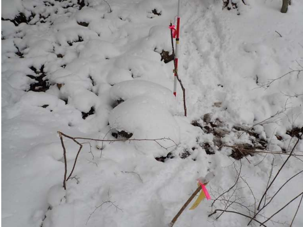
R-5 測点 59.6m(暗渠工 \phi=600 )
