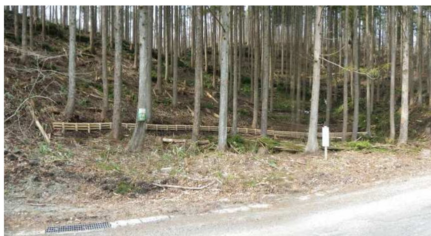
丸太筋工による放射性物質対策のイメージ
