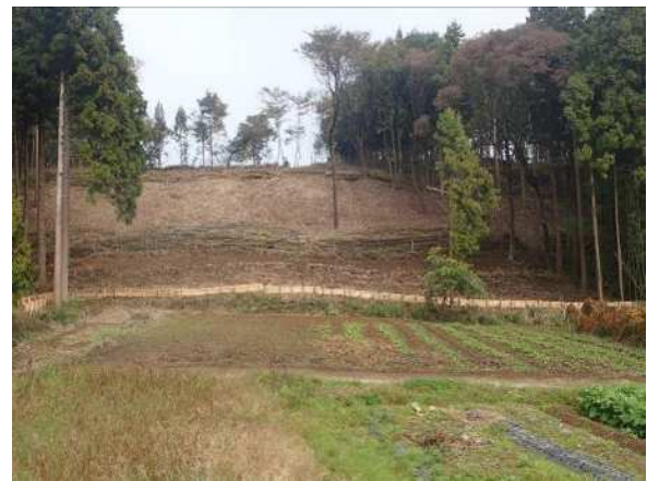
丸太柵工による放射性物質対策のイメージ
