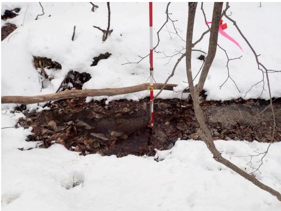
R-20 測点 536.6m(暗渠工=φ 600)
