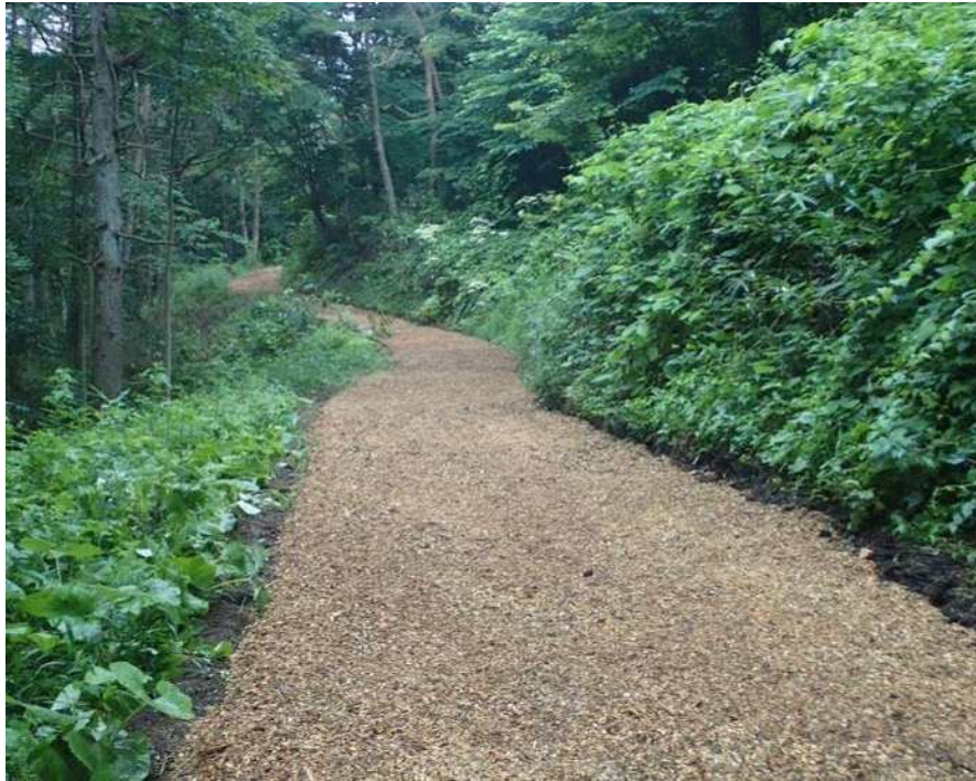
作業道のチップ敷均し状況
