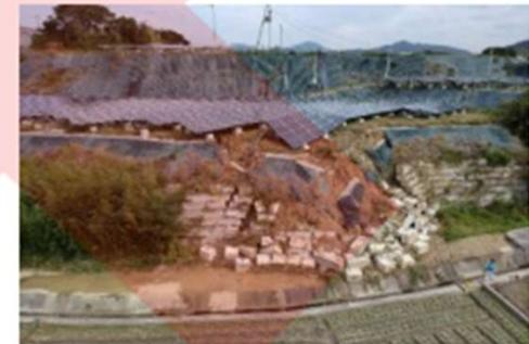
法面保護工が崩れて流出した事例
