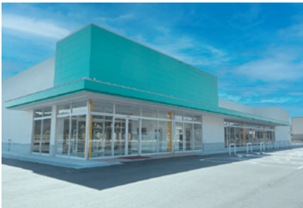
式の終了後に内覧会も行われました。今後は完成した施設で店舗のオープンに向けた準備が進められます。
