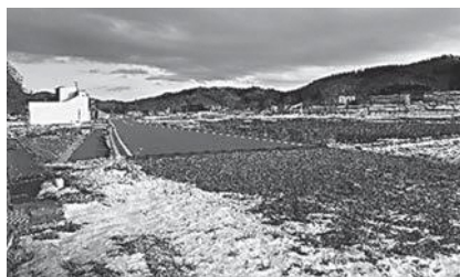
▲工事の止まっている県道12号線バイパス
