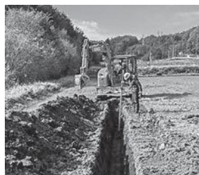
▲暗渠工事の様子(二枚橋)
