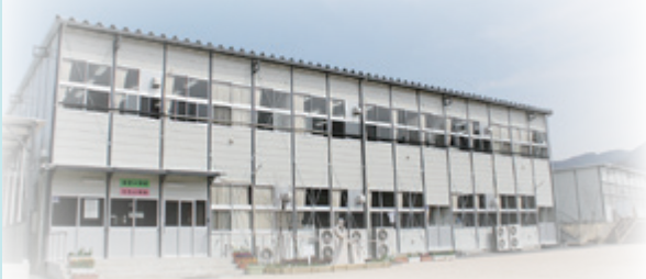
草野・飯樋・白石小学校仮設校舎
