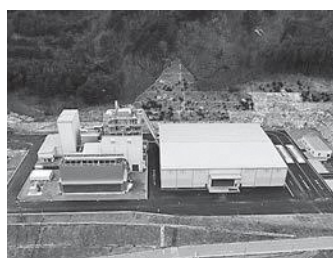
▲飯館村の木質バイオマス施設
