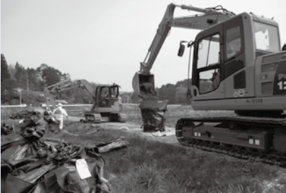
左:重機を使って表土削り取りをしているようす 下:削り取った表土は、フレキシブルコンテナに詰められます
