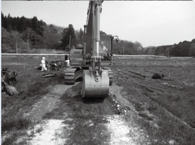
左:重機を使って表土削り取りをしているようす 下:削り取った表土は、フレキシブルコンテナに詰められます
