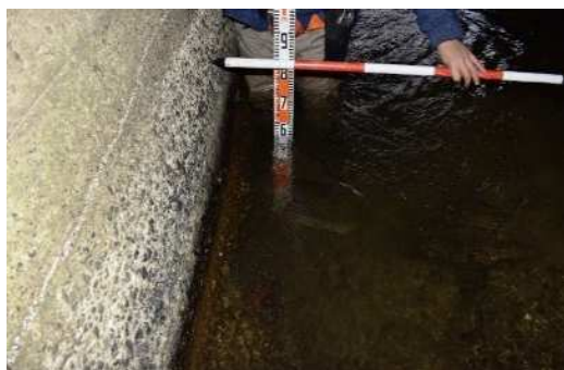
71. 八和木荒屋敷1号橋：RC床版橋 (橋長：4.20m、1970年竣工)
