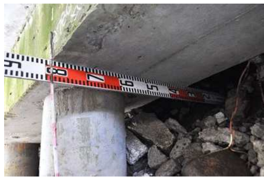
92. 車大房木1号橋：RC床版橋 (橋長：4.80m、1972年竣工)
