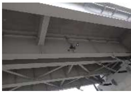
ドローンによる桁下の点検
