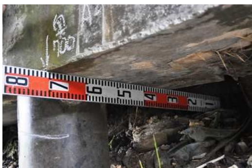
96. 一楽1号橋：RC床版橋 (橋長：3.25m、1972年竣工)
