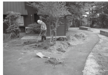
▲きこりのコテージ付近の表土を手作業ではぎ取り
