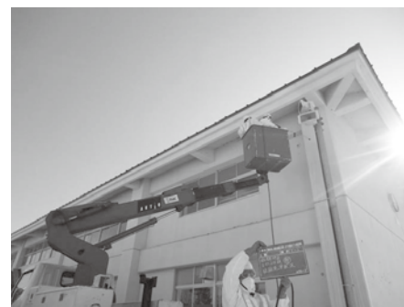
▲1月に行った草野小学校の外壁の除染のようす
