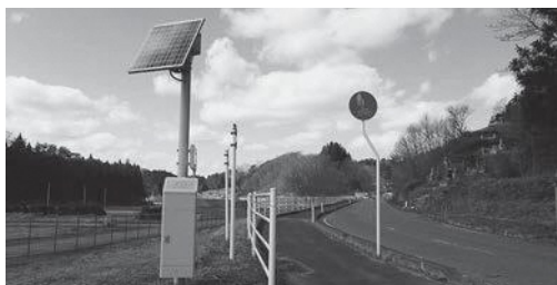
▲村内に設置されているモニタリングポスト
