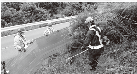
▲除染廃棄物の仮々置き場造成のために除草するようす（二枚橋）
