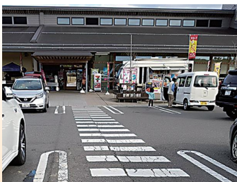
▲道の駅の修繕が必要な箇所
