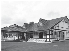
▲地震の被害を受けた「きこり」
