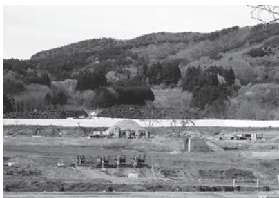
▶現在の長泥地区の特定復興再生拠点工リア造成工事の様子（令和4年4月時点）
