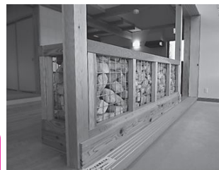
▲③石の蓄熱体：温室に差し込む太陽熱を蓄え、室温の急激な変化を防ぎます。
