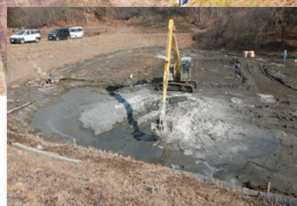
前田地区広平第2ため池の対策工事(10月)
