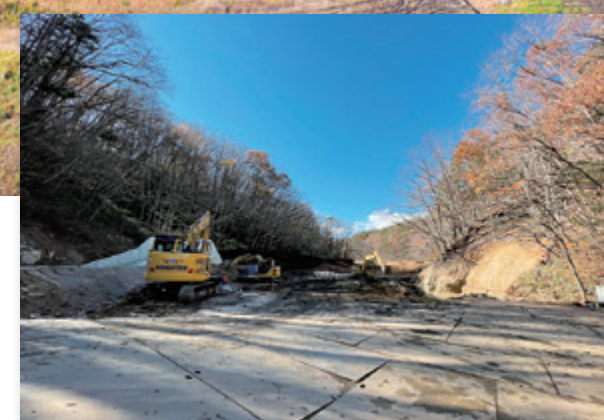
前田地区平吾入のため池補修工事(11月)
