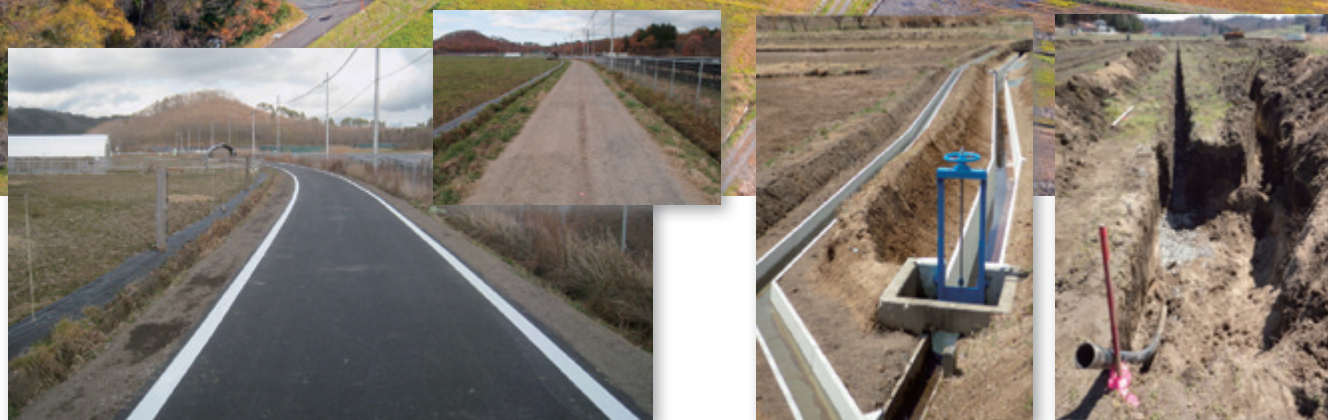
農道舗装工事(松塚地区) ※右上は施工前の写真
