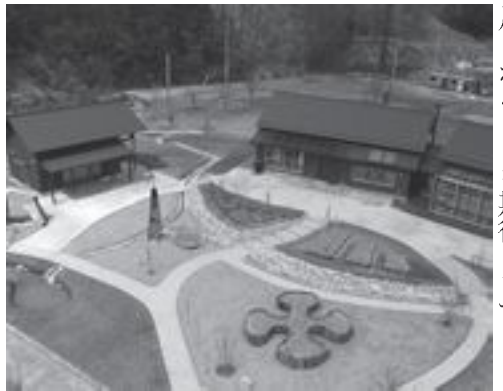
▲役場庁舎西側に建築された「までいな家」
