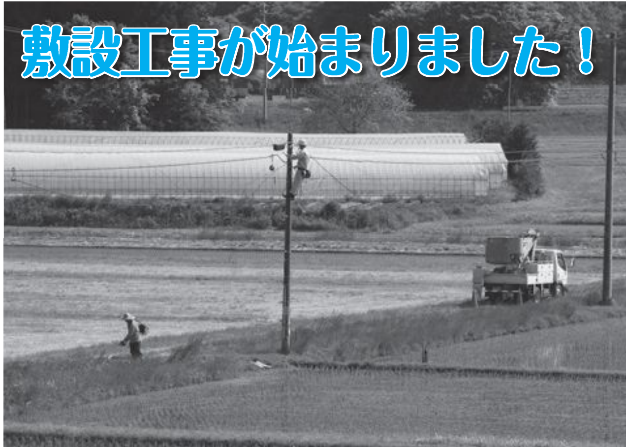
▲光ファイバ敷設工事のようす（写真は比叡地区）
