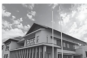
▲新たに整備を行った旧飯樋小学校(現・飯館村地域防災センター)
