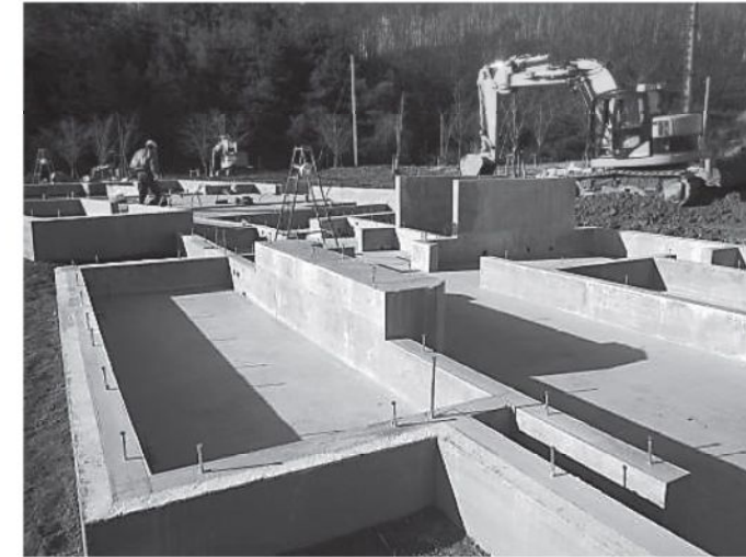
▲写真：基礎断熱施工の様子
